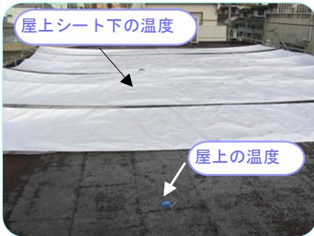
施工例：工場屋根 遮熱シート
