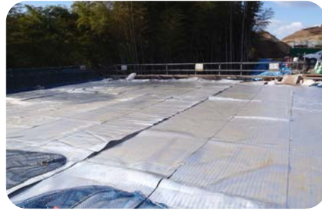
コンクリートの養生として
