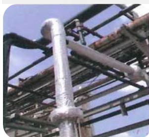
屋外配管の遮熱断熱として
